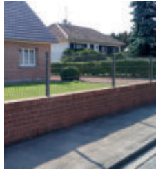
Pose sur muret
